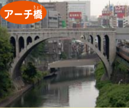
アーチの弧の形は、石が互いを支えるような構造になっています。
