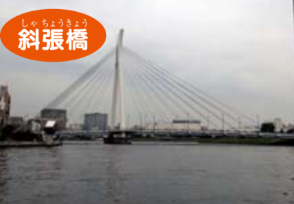
支柱からのびた複数のワイヤーが、力を分散させています。
