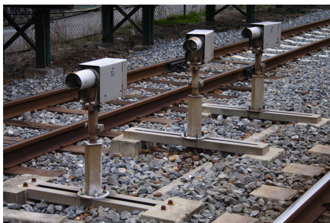
Fig.3.2 踏切障害物検知装置(送信機側)
