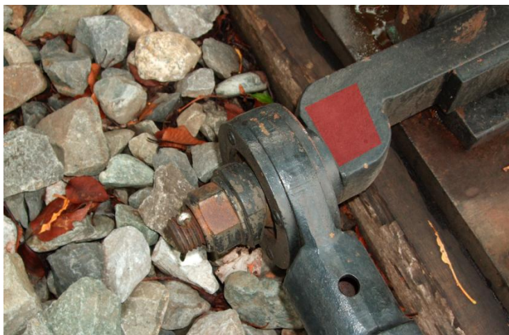
図 3.1 加速度センサ設置位置
