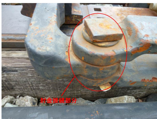
図 2.10 フロントロッド肘金接続部分
