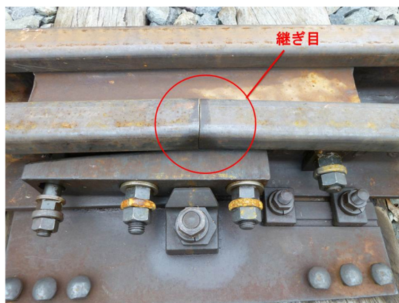
図 2.4 トングレール継ぎ目
