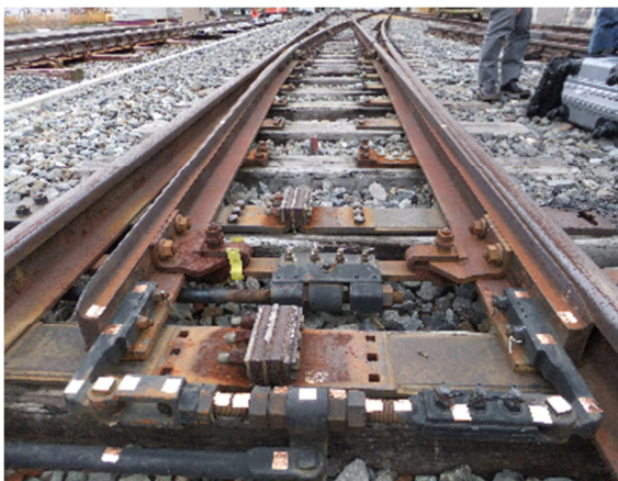
図 3.9 加速度センサ取り付け図
