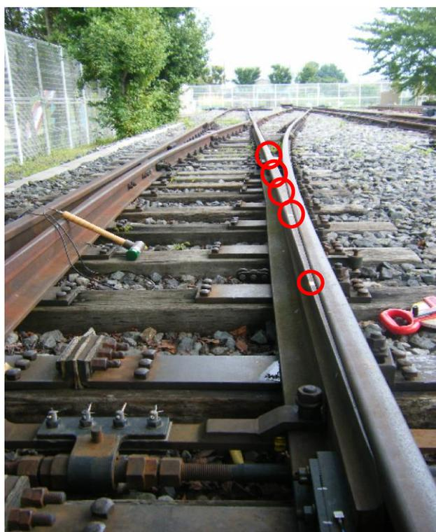
図 3.18 加速度センサ取り付け位置
