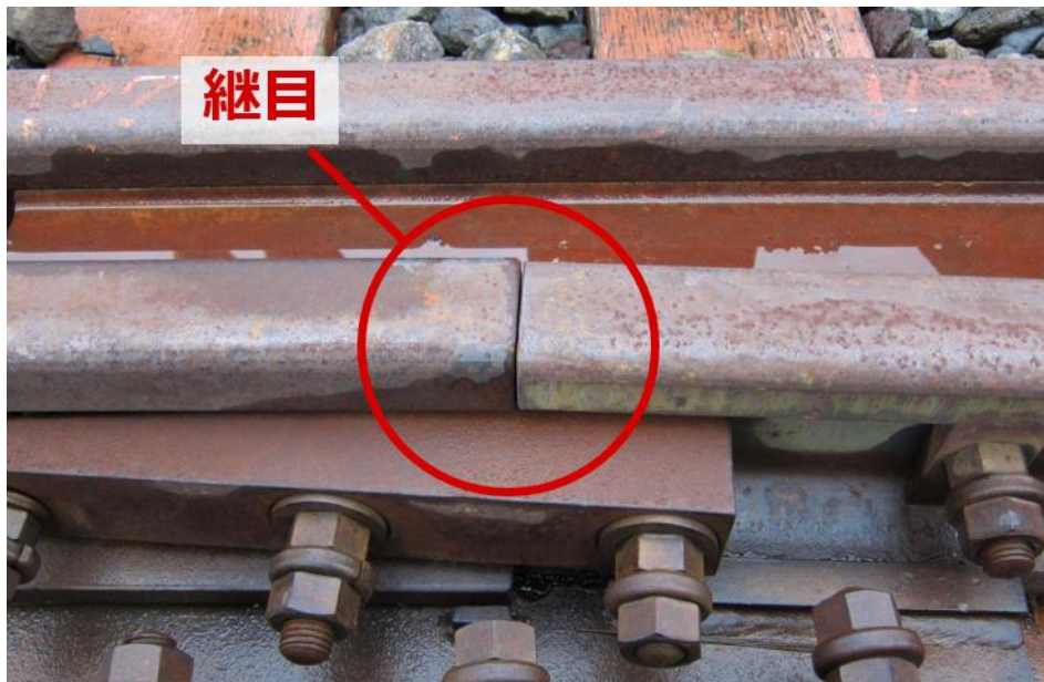
図 2.4 トングレール継目（関節方式）
