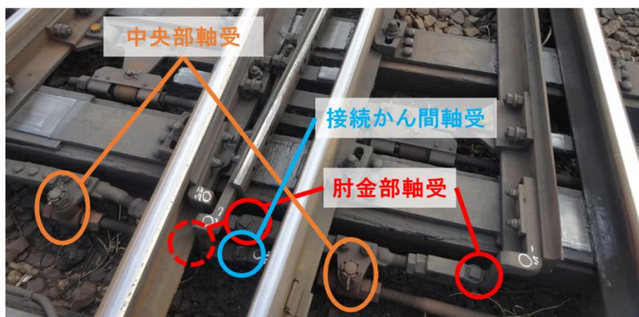
Fig. 3.1 フロントロッドの軸受位置
