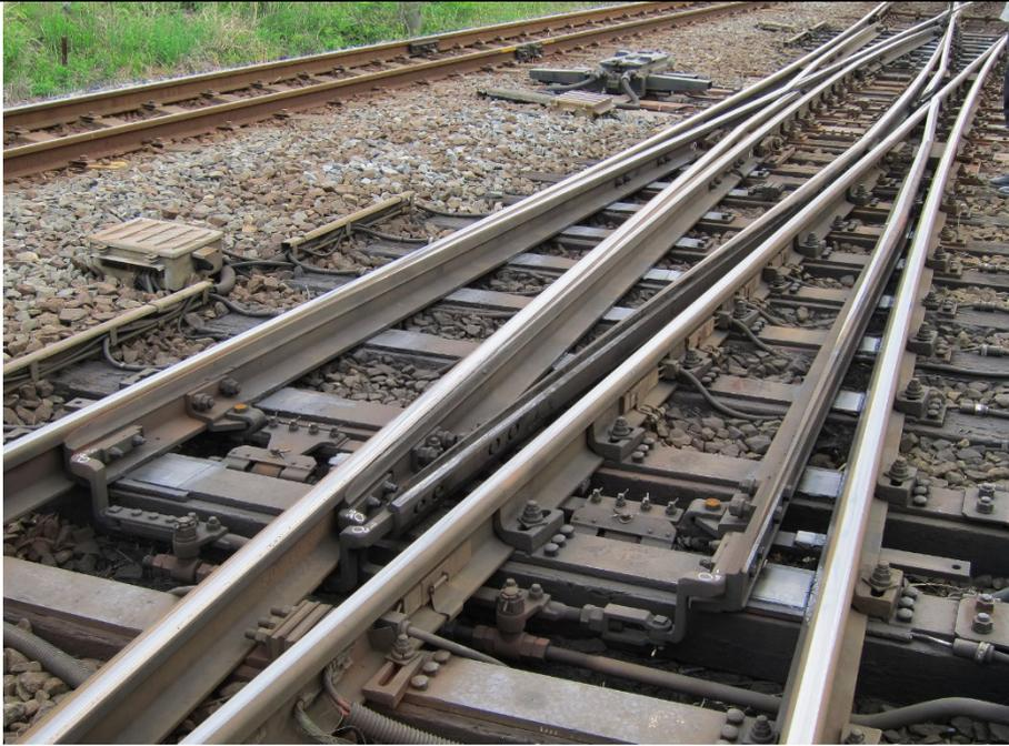
Fig. 2.5 ダブルスリップ分岐器全体図
