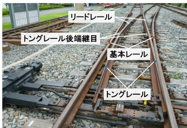
Fig. 2.4 分岐器を構成するレール
