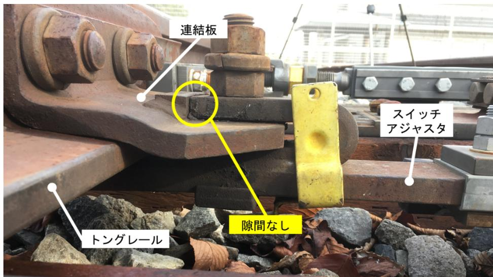
Fig. 2.6 スイッチアジャスタと連結板の接続部（密着側）
