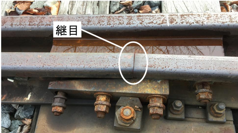
Fig. 2.2 トングレール後端部継目
