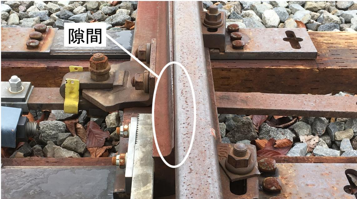
Fig. 2.14 トングレール先端と基本レールの間に隙間が生じた状態
