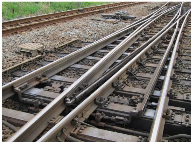
図 2.4 ダブルスリップ分岐器外観
