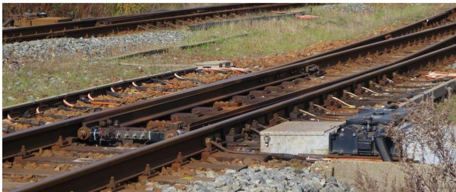
図 2.1 営業線に設置された分岐器（普通分岐器）
