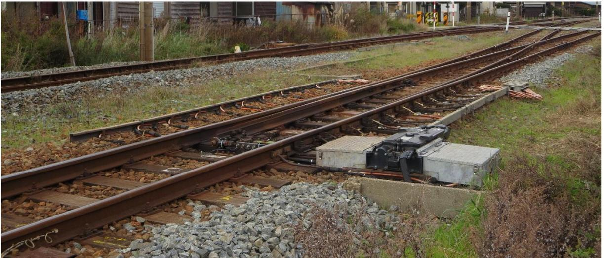
図 2.1 営業線に設置された普通分岐器
