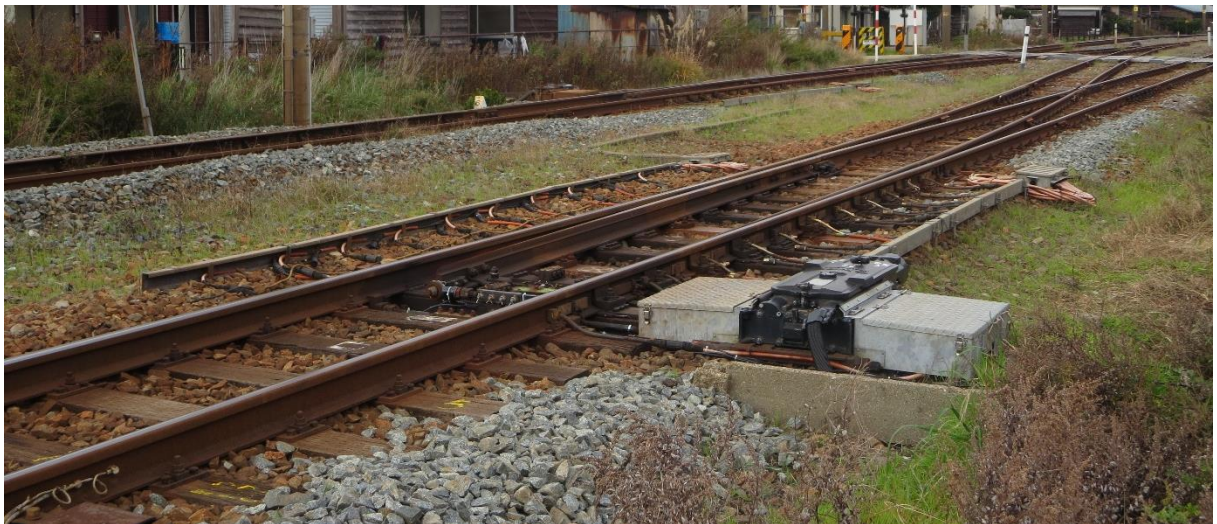
図 2.1 営業線に設置された普通分岐器
