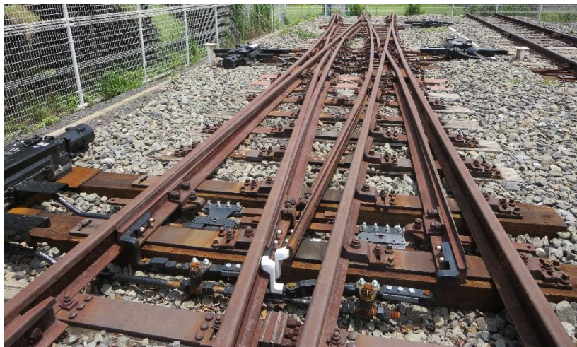
図 2.4 ダブルスリップ分岐器の外観
